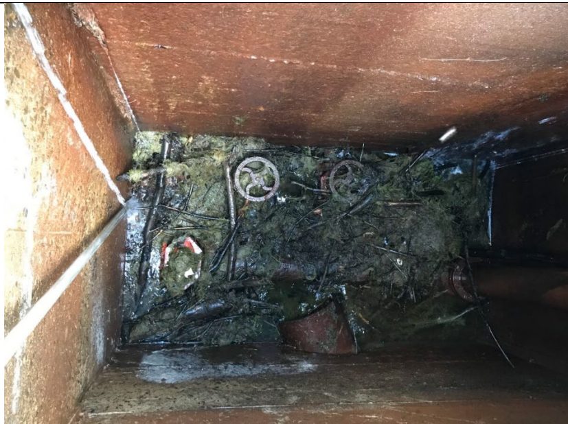
Photo 2 – Nettoyage préliminaire des vannes et de la conduite d'évacuation (2023-07-27).
