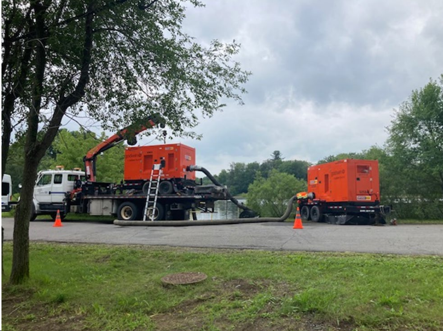
Photo 4 – Pompes installées en bordure du barrage pour accélérer l'abaissement du réservoir.
