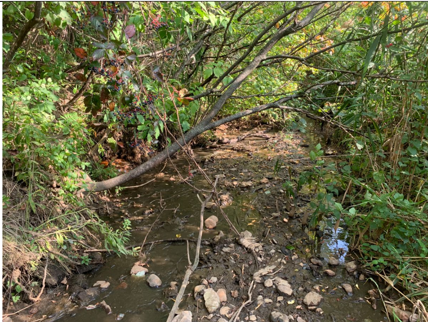
Photo 8– État général du fossé récepteur des eaux du barrage Béram (2023-09-25)
