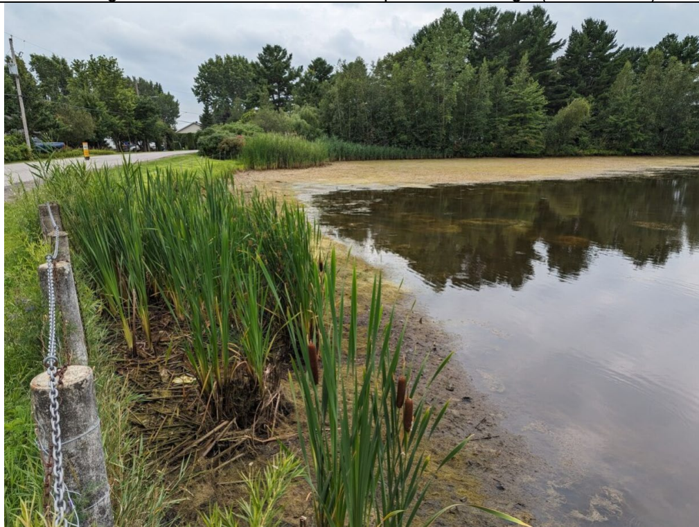
Rive gauche pendant l'abaissement du réservoir (2023-08-03)
