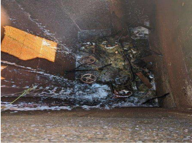
Photo 1 : Fond du puits à l'amont du barrage
