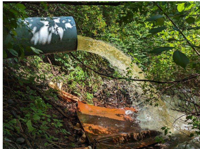
Photo 4 : Débit sortant à l'aval du barrage
