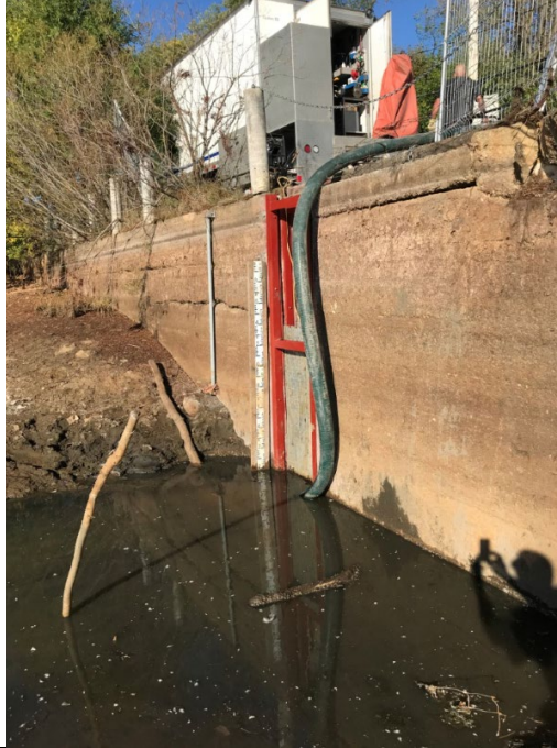
Photo 9 – Cadre métallique installé dans l'embrasure du seuil du barrage pour stabiliser les parois de l'ancienne chambre de contrôle du barrage.
