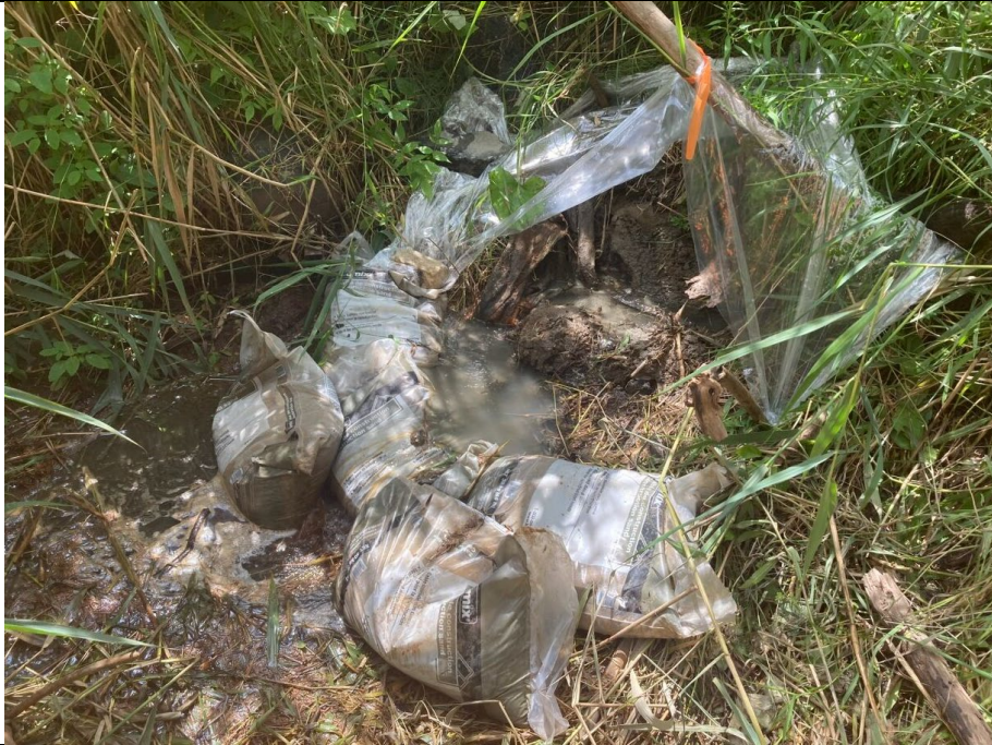
Photo 3 – Première venue d'eau et bassin de rétention temporaire installé au pied aval de la digue Béram (2023-07-31).
