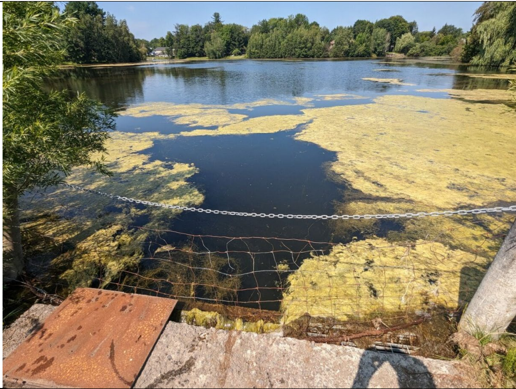
Allure générale du réservoir amont à partir du barrage (2023-07-24)
