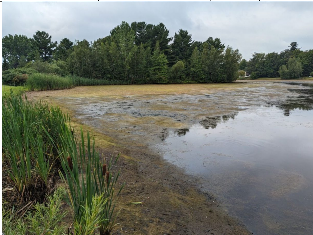
Rive gauche pendant l'abaissement du réservoir (2023-08-04)
